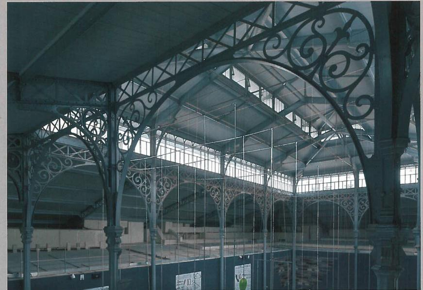
La toiture à triple niveau a été restaurée et complétée d'un système de caissons encastrés avec évacuation des eaux pluviales. © Didier Boy de la Tour
