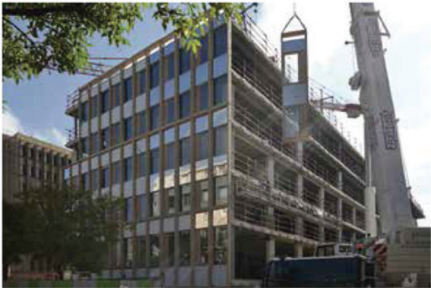
▲ Montage du pignon ouest donnant sur l'avenue Pasteur.
