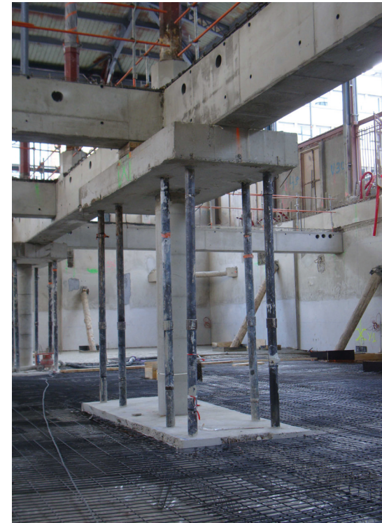
Reprise en sous-œuvre de la structure Underpinning the structure
