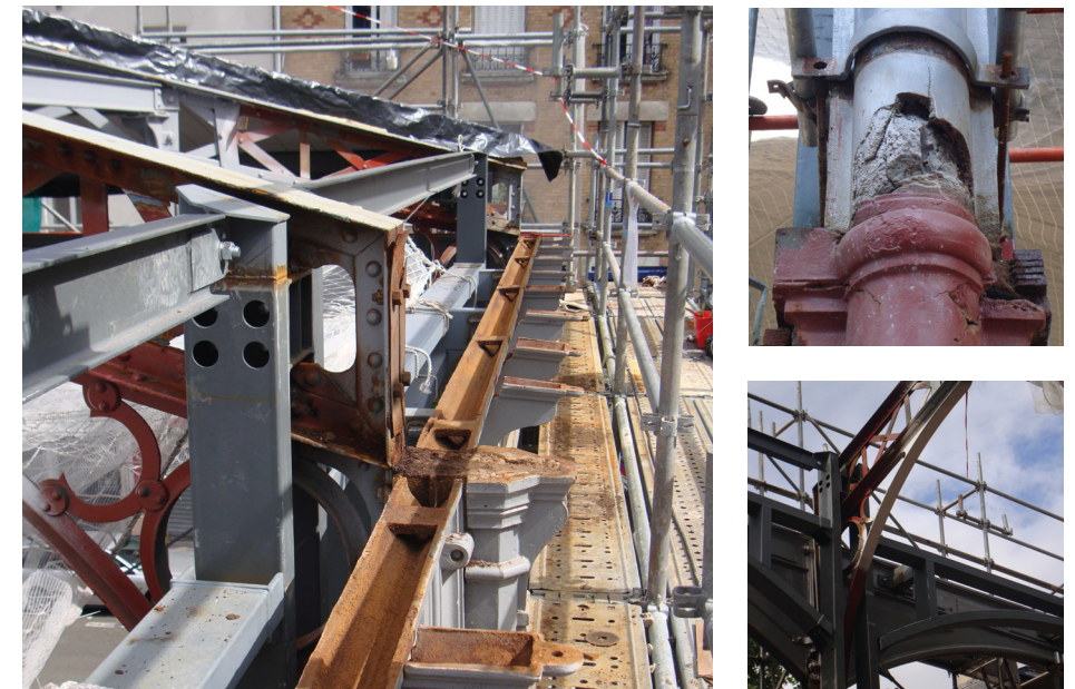
Reprise des structures existantes et association d'une deuxième structure existante Remedial works to existing structures and association of a second existing structure
