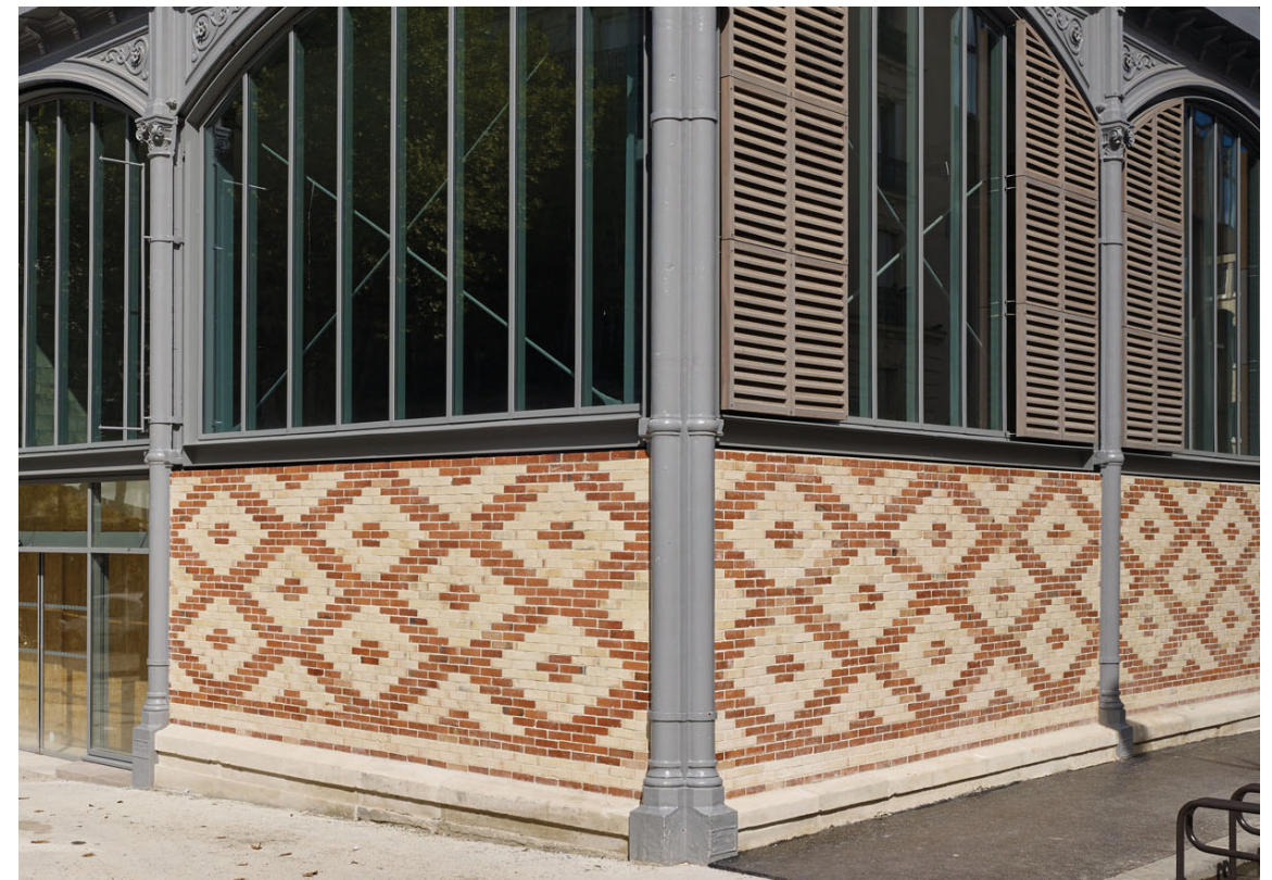
Restauration des soubassements en brique Restoration of the brick support walls
