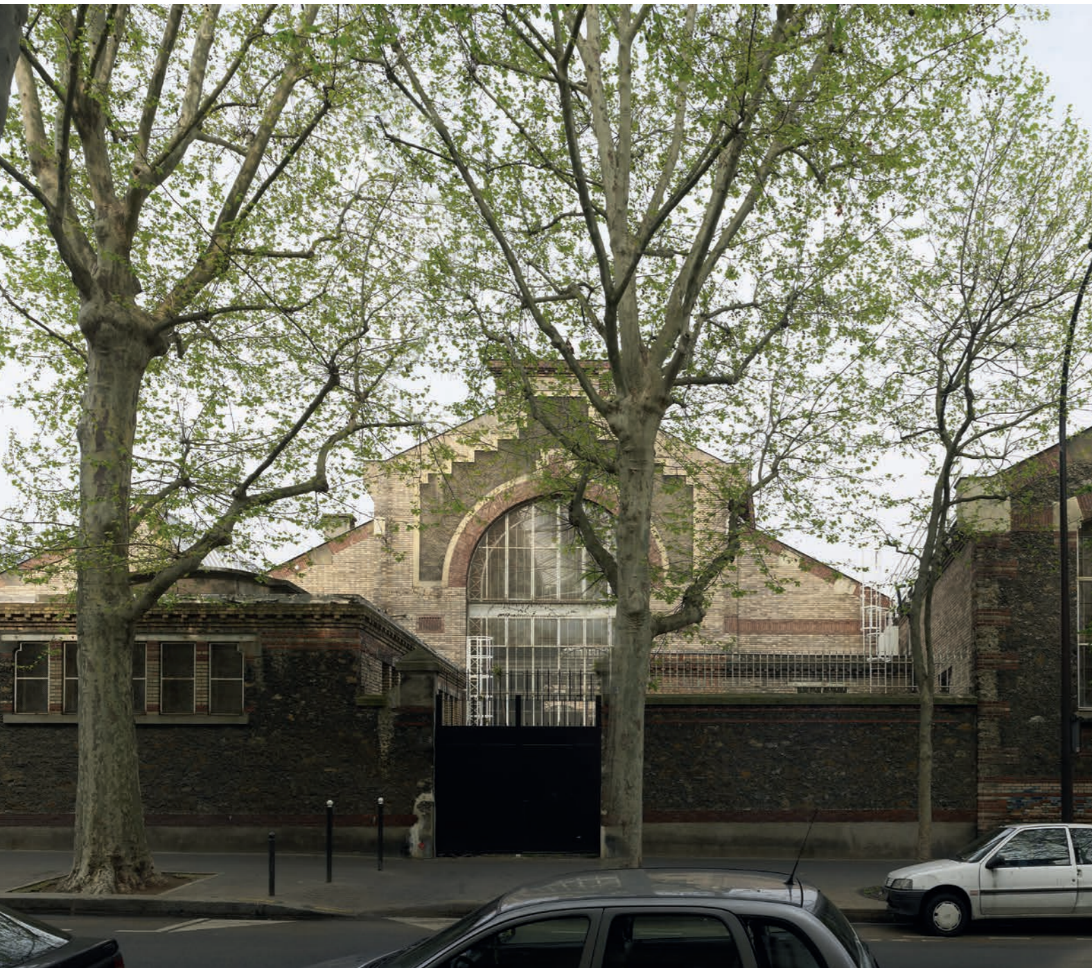
Halles de recherche avant travaux
