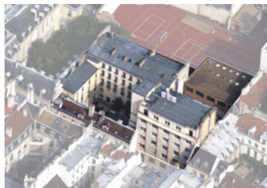
Vues aériennes des bâtiments avant projet
