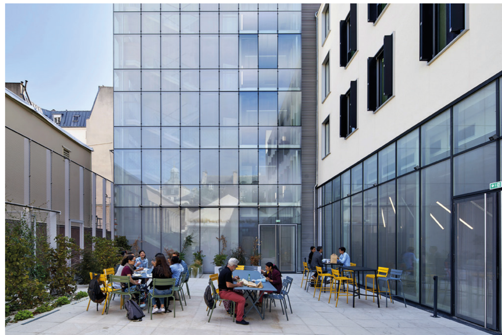
→ Un espace extérieur planté prolonge les lieux collaboratifs du rez-de-chaussée. © Michel Denancé
